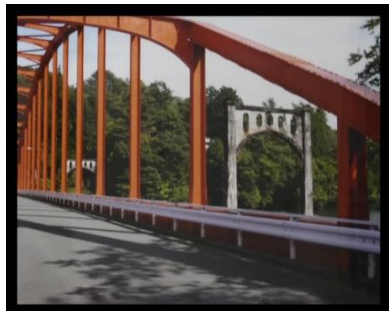
矢崎陽一／信州木曽谷の廃橋と新橋
