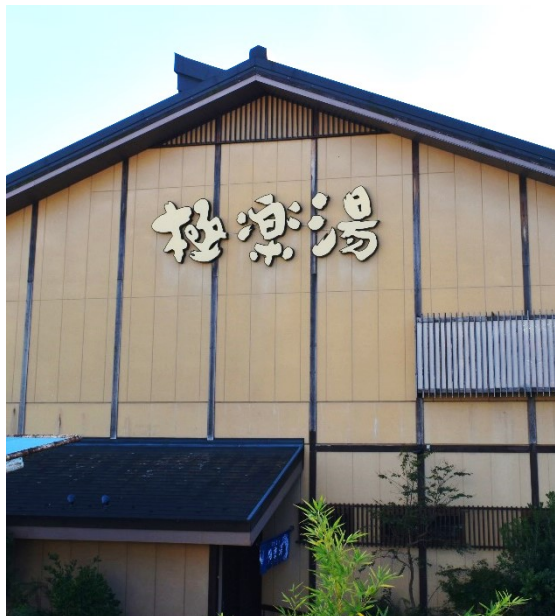
温泉「多摩センター極楽湯」建屋正面外観
